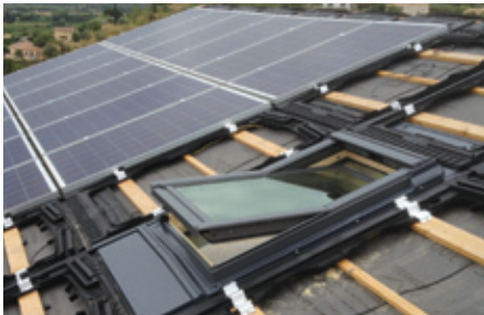
Eenvoudige montage op latwerk
