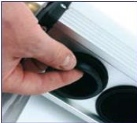
9.) Afdichtingsrubbers in de collectorbehuizing plaatsen.
